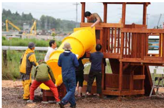
ボランティアによる遊具の組み立て、設置
